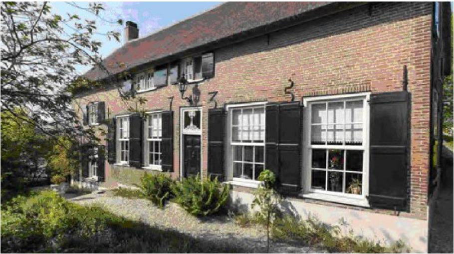
2. De voorgevel van de boerderij. Aan de rechterzijde (dijk zijde) de dijkkamer, dan de voordeur met gang, vervolgens de middenkamer waar de kelder onder lag en aan de linkerzijde de voormalige keuken met toegang naar de kelder. Boven de keuken is een tussenverdieping.
